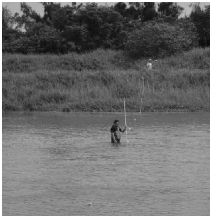
圖 10 在兩斷面樁間建立測量線
