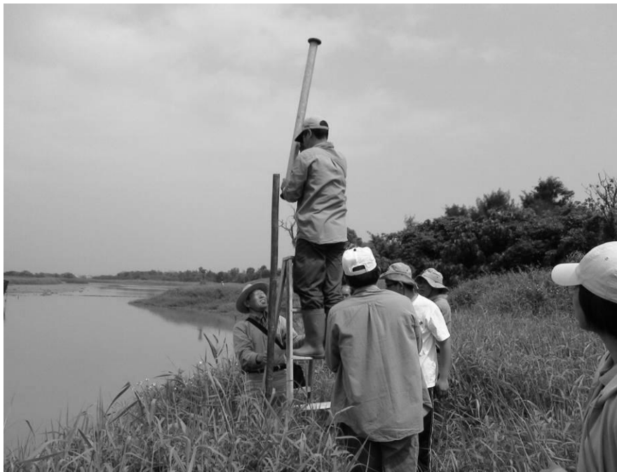
圖 4 釘置溼地沿岸十公尺木樁
