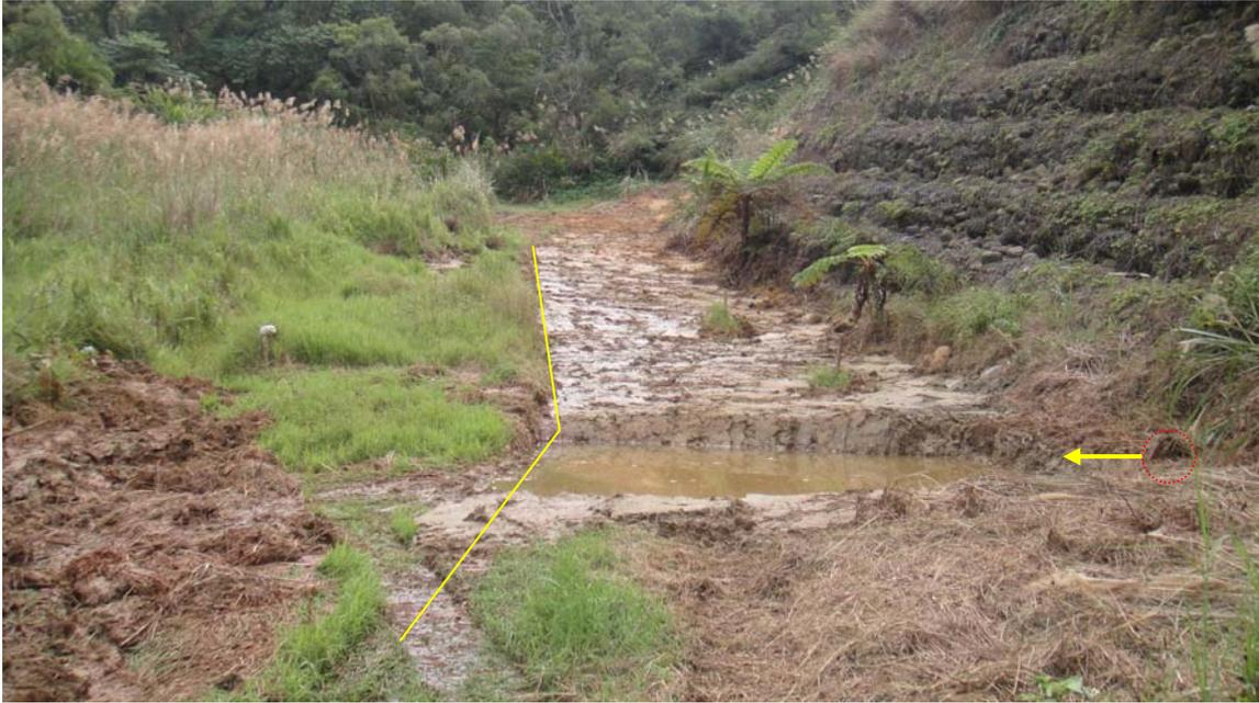
圖 2-1-2 圖示紅圈圈處，位於蛇籠的底部，不斷有水流出，池中水呈泥黃色。
