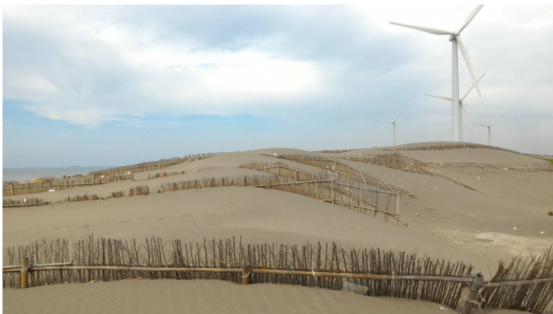
圖 6、許厝港重要濕地內老街溪以南的沙丘、定沙工程與風機景觀
