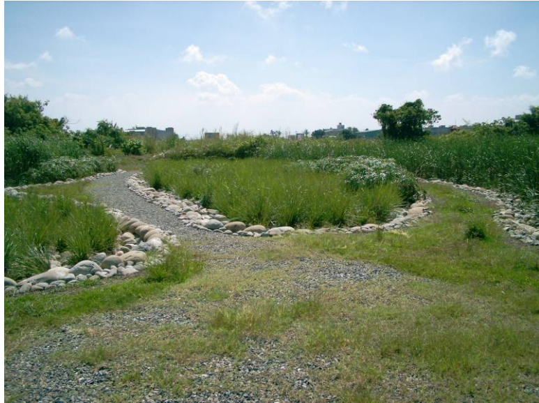
圖 5 表面下流動(SSF)濕地：水在礫石表面下層流動而被淨化，礫石層表面則是挺水性水生植物生長，可稱為污水花園。SSF 濕地的污水淨化功能一般優於 FWS 濕地。
