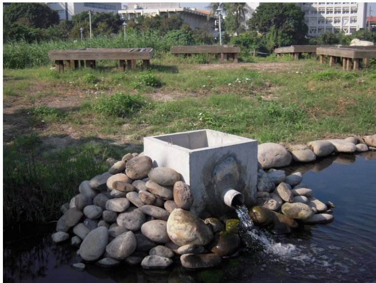
圖 6 SSF 濕地的出流口，同時也是維持表面下流動的水位控制設施。
