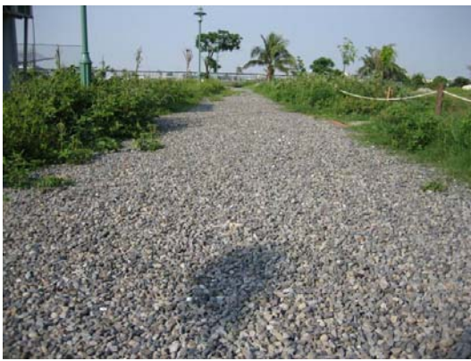
圖 14 以廢磚塊(左)及碎石(右)為材料的透水面鋪。
