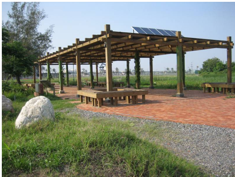
圖 10 休憩花架：主要建材是回收自原鴨寮的舊建築廢材。
