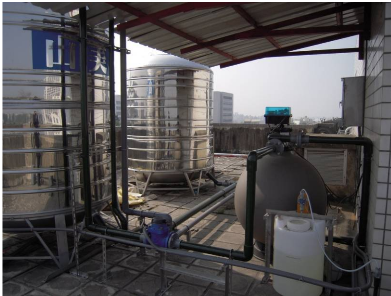
圖 17 本校人工濕地放流水應用於沖廁系統之砂濾與加氯消毒處理單元
