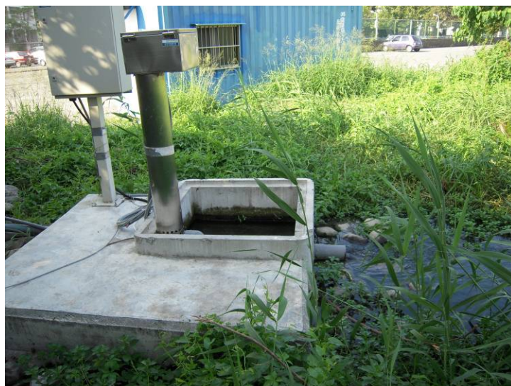
圖 4 污水進流口：進流污水由此處流入人工濕地，然後重力方式流經後續單元。
