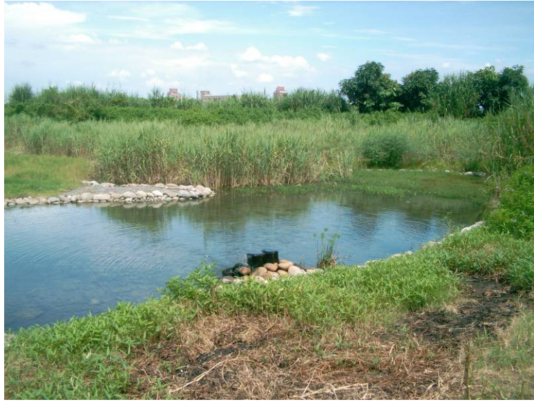
圖 7 表面流動(FWS)人工濕地：為模擬天然濕地條件的污水處理濕地，其生態保育功能優於 SSF 濕地。
