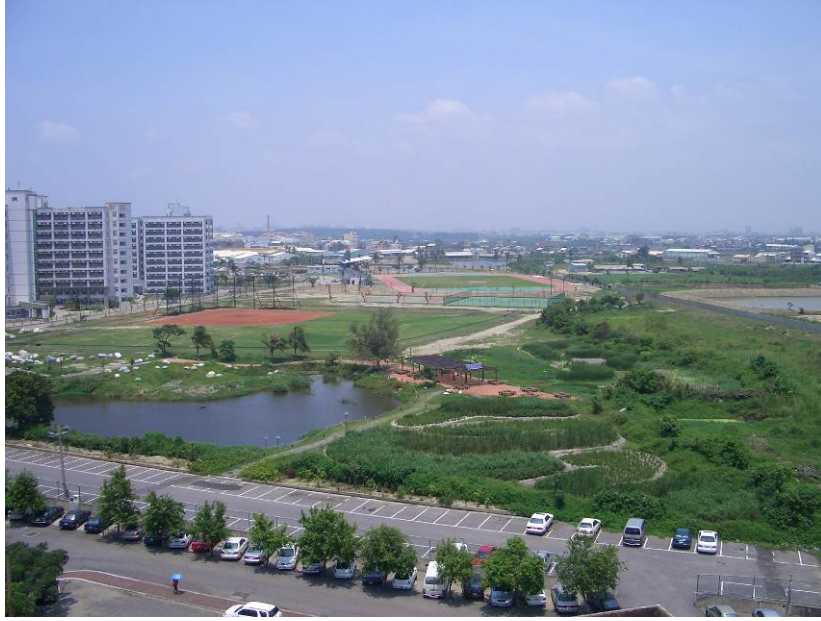
圖 1 嘉南藥理科技大學人工濕地的鳥瞰圖，她已被列為台灣 75 個重要濕地中編號第 58 個濕地，屬於地方級的重要濕地。
