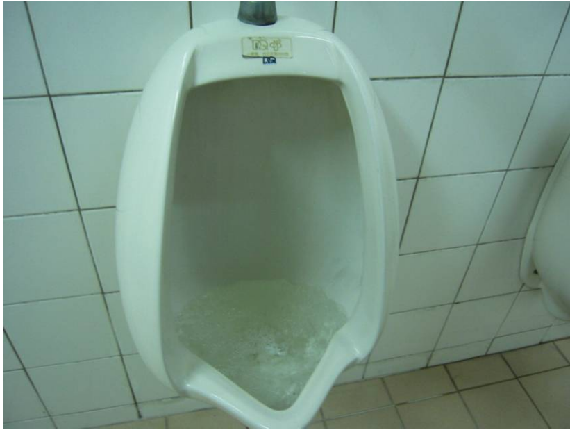
圖 18 本校人工濕地放流水經過濾與消毒程序後，應用於沖廁之目視水質
