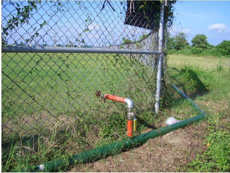
圖 16 人工濕地淨化後的水經加壓管線回收再利用棒球場及操場草皮的澆灌。
