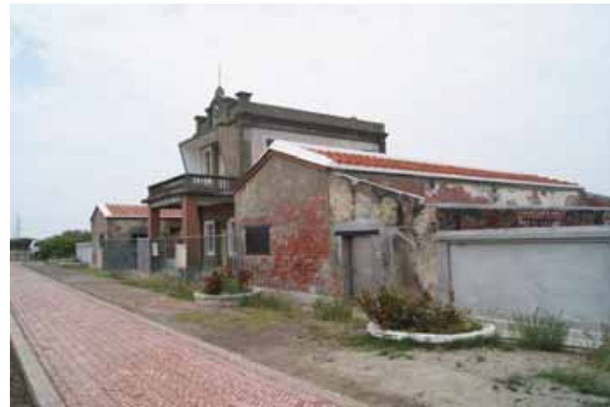
圖 4-2、修復後的鹽田辦公室與 2 側建物，原本是磚牆，後來均用水泥重砌。
