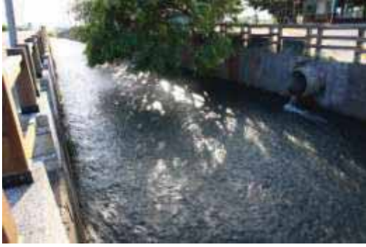
照片 47 華中街大排水溝
