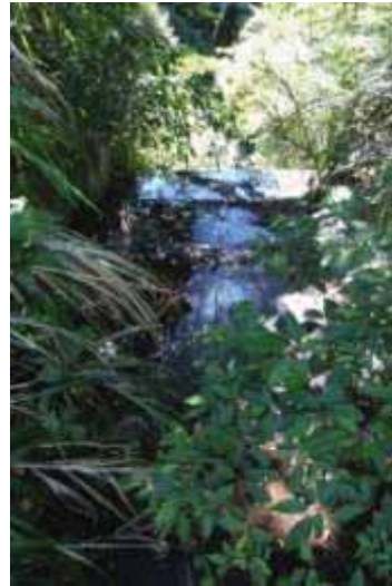
照片 66 攔水壩體後側的排水溝
