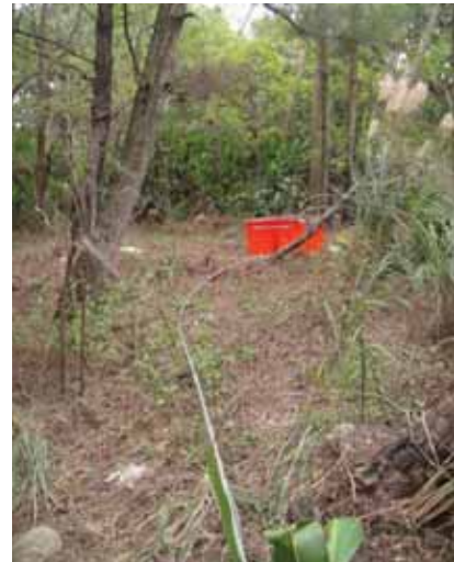
圖 3-9 並聯的水箱，水從右下方流出流至 Z1 區。
