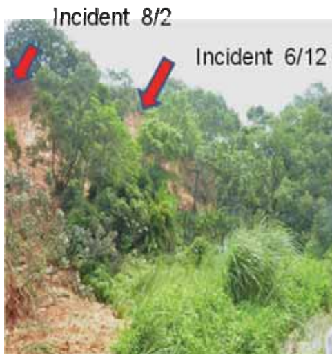
北坡兩次崩塌的位置
