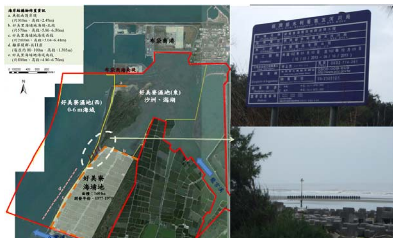
圖 3.31 好美寮海堤突堤治理工程
