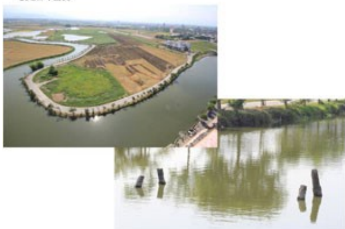
復建百年舊橋
