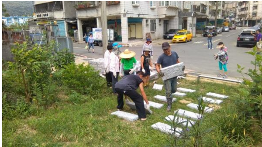
20150922 社區志工參與鋪石階
