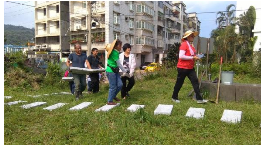
20150922 社區志工參與鋪石階
