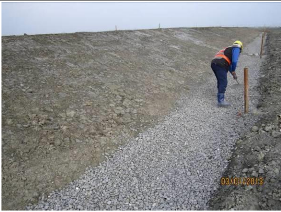
完工後現況照片
