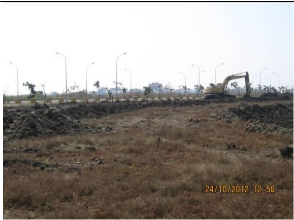
新設渠道挖運
