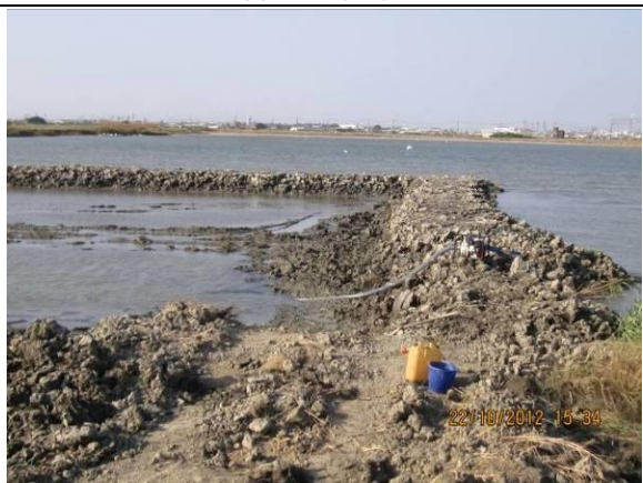
臨時圍堰內側抽水
