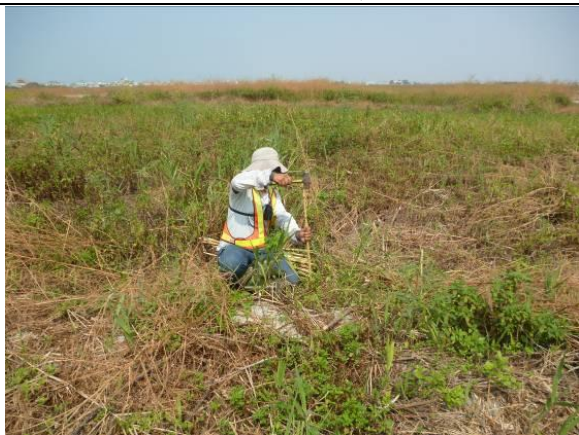
測量放樣打樁
