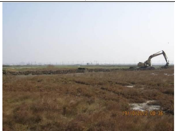
新設渠道挖運
