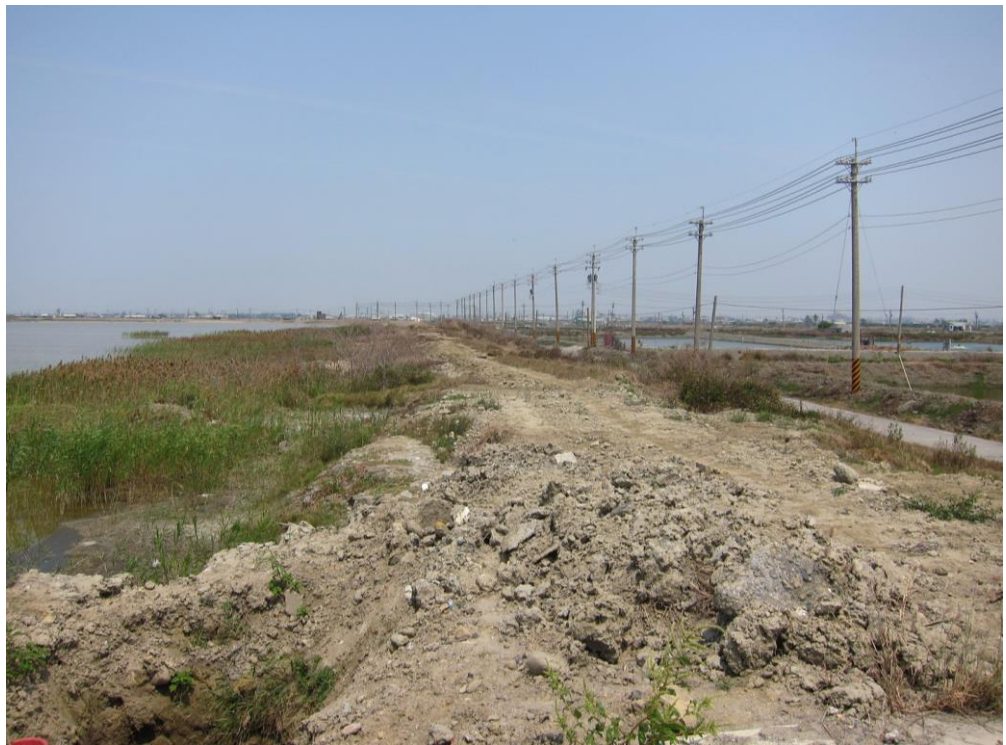
照片 1 基地東側既有土堤現況
