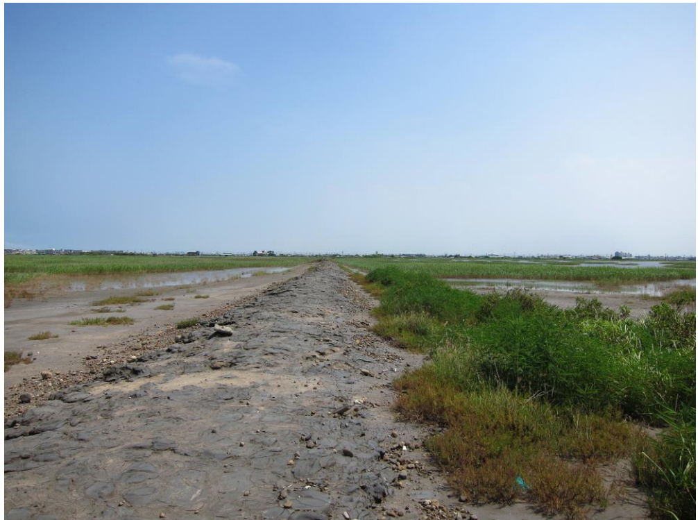
照片 3 園區內既有土堤現況
